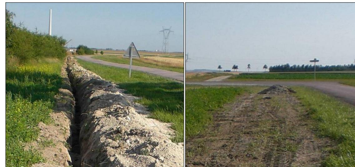
Photo 132 : Rebouchage de tranchée après passage des câbles électriques (Source : BE Jacquelin et Chatillon)
